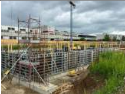
Figura 300. – I lavori di costruzione delle 3 palazzine in social housing a Sanpolino (maggio 2025)
