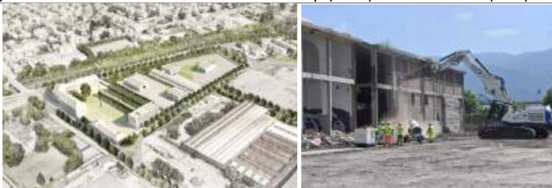
Figura 305. – Render della Cittadella dei Servizi nell'ex caserma Papa (sinistra) e lavori di demolizione (destra)
