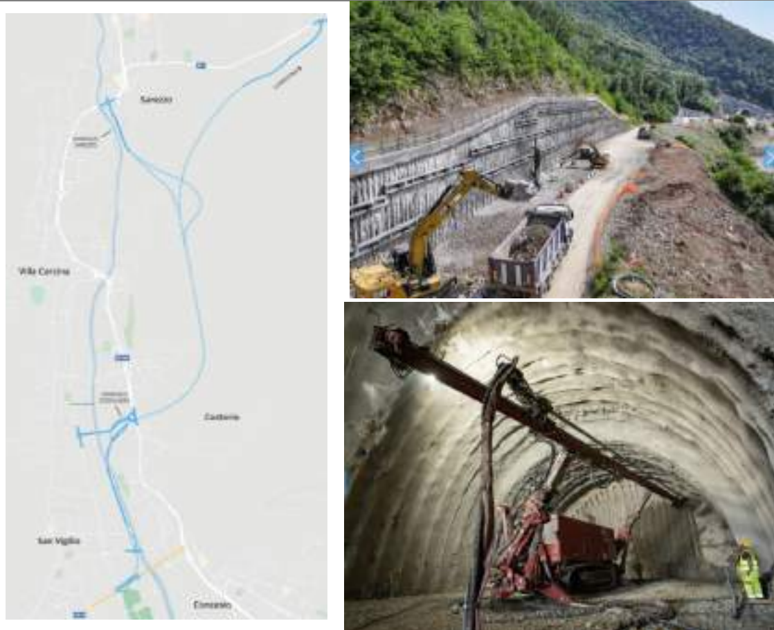
Figura 298. - Tracciato in costruzione (Anas) e aggiornamento sullo stato dei lavori (a luglio 2025)
