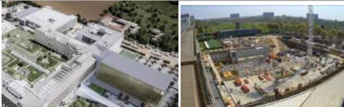
Figura 304. – Render de la nuova torre delle degenze (sinistra) e lavori per l'area bunker di radioterapia (destra)
