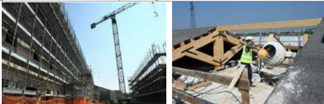
Figura 308. – Lavori in corso all'ex casa di riposo Arici Sega
